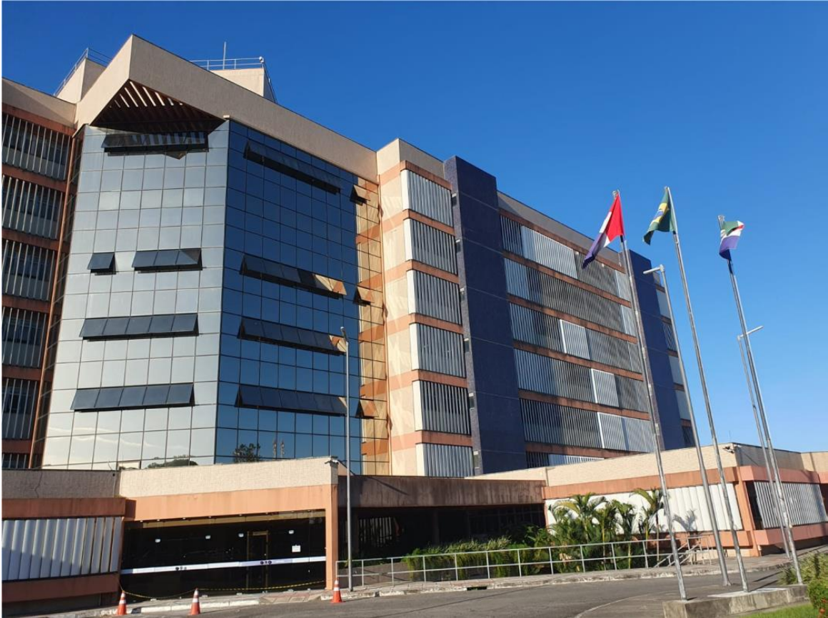
Prédio da Justiça Federal, na Av. Menino Marcelo, s/nº, em Maceió
